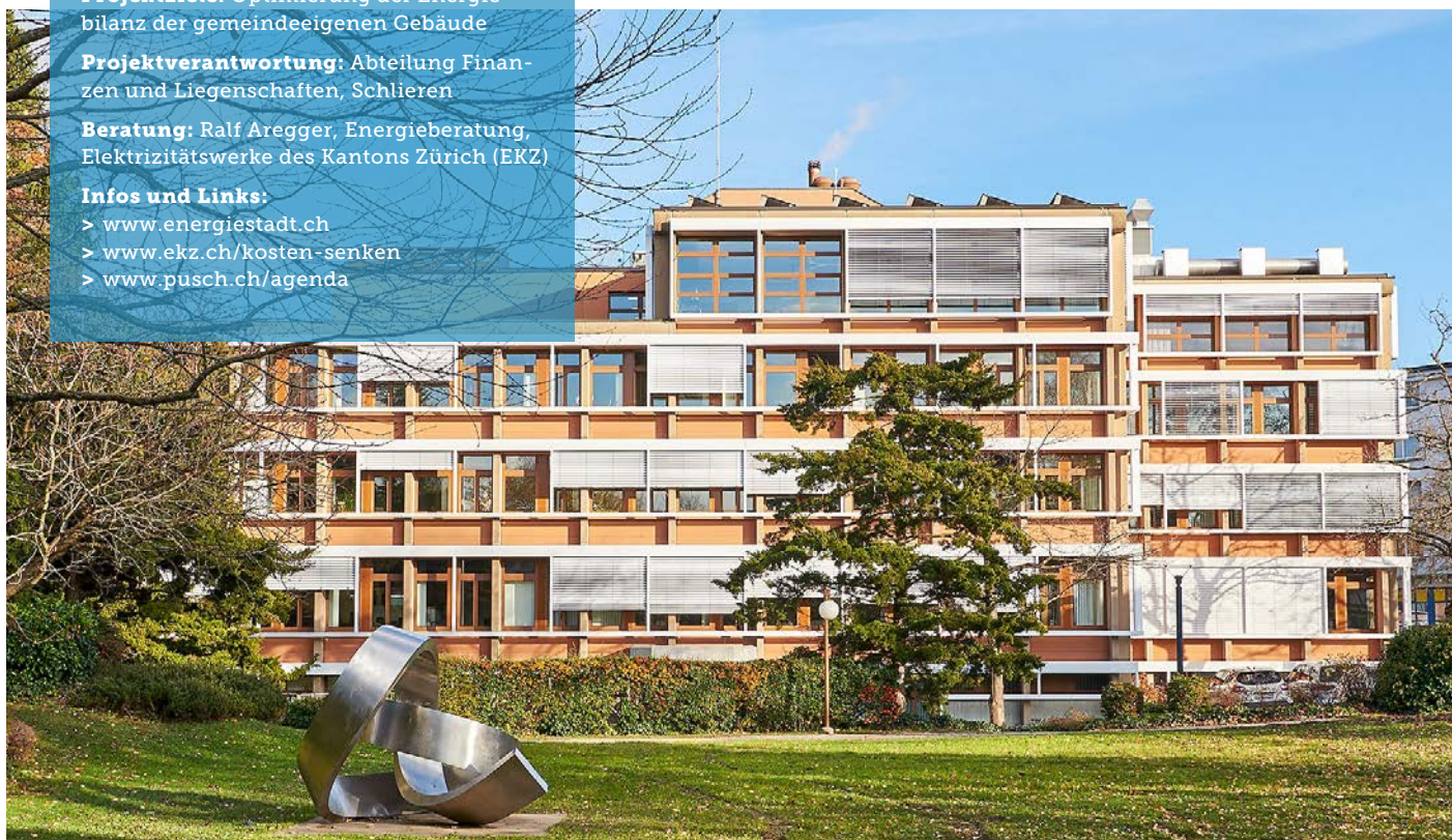
Schlieren überprüft die gemeindeeigenen Gebäude mit der Efficiency-Gap-Analyse, um den Energieverbrauch mit kleineren Massnahmen und – wo nötig – auch mit grösseren Investitionen zu optimieren. (Quelle: EKZ)
