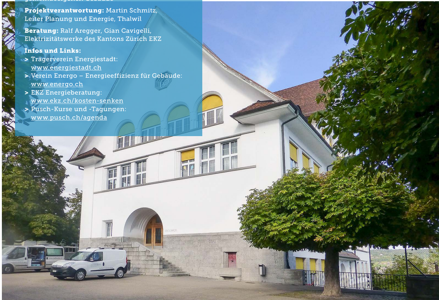
Eine externe Analyse der Gebäudeeffizienz hat im Schulhaus Oeggisbühl verschiedene Schwachstellen aufgedeckt. (Quelle: Mirella Wepf)
