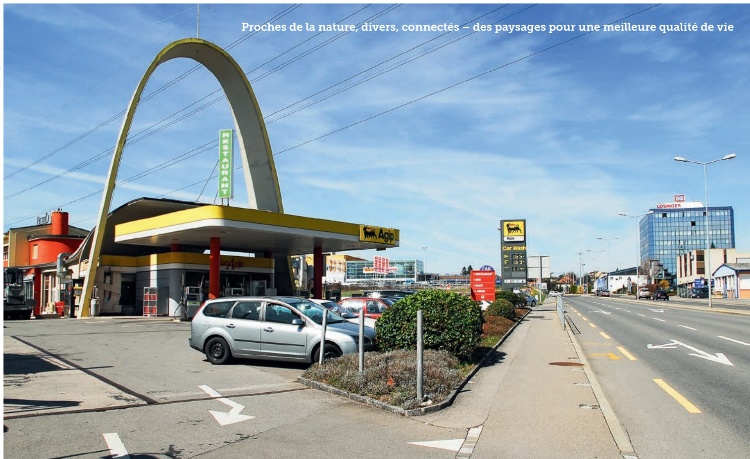
Dans l'Ouest lausannois, l'histoire et l'identité du lieu ont été mises en scène de manière à ce que des objets particuliers, comme la «station-service Arc-en-ciel» de Bussigny (VD), deviennent des marques d'identité.
