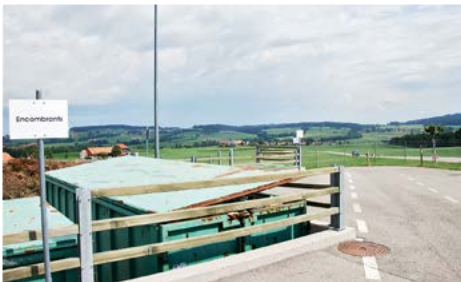
Un arrêt de bus permet théoriquement l'accès à la déchèterie en transports publics. Une limitation de la vitesse de la route de transit aux abords de la déchèterie diminuerait les risques de collision.
