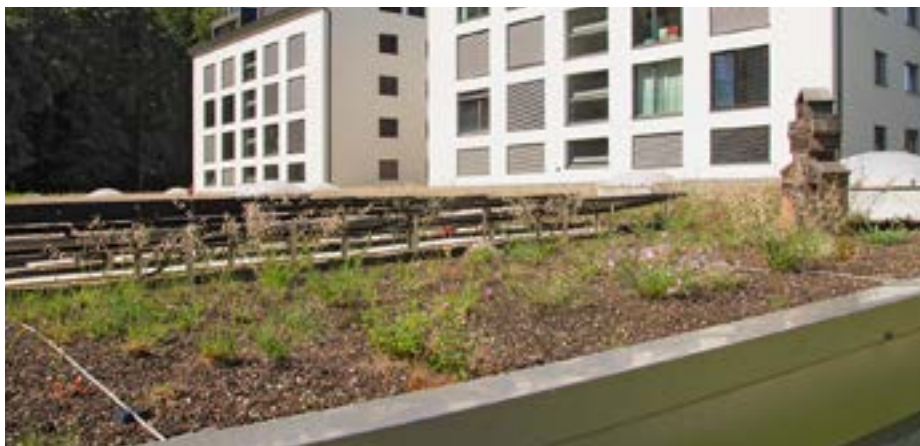
La forêt et les bâtiments alentour ont obligé à limiter la surface de panneaux photovoltaïques sur le toit, mais pas celle qui a été végétalisée.
