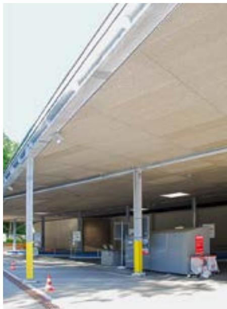
Des panneaux acoustiques au plafond réduisent le bruit pour le bien-être du personnel et du voisinage.
