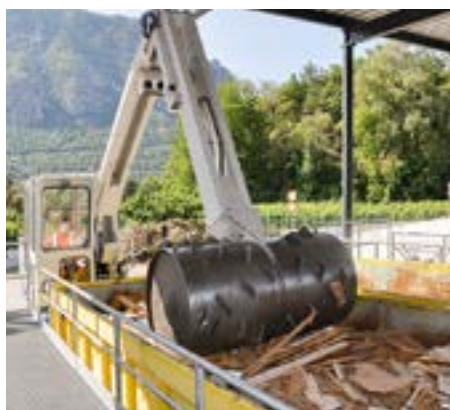
Un rouleau permet de compresser le bois ou les encombrants et de diminuer le nombre de transports nécessaires à leur évacuation.
