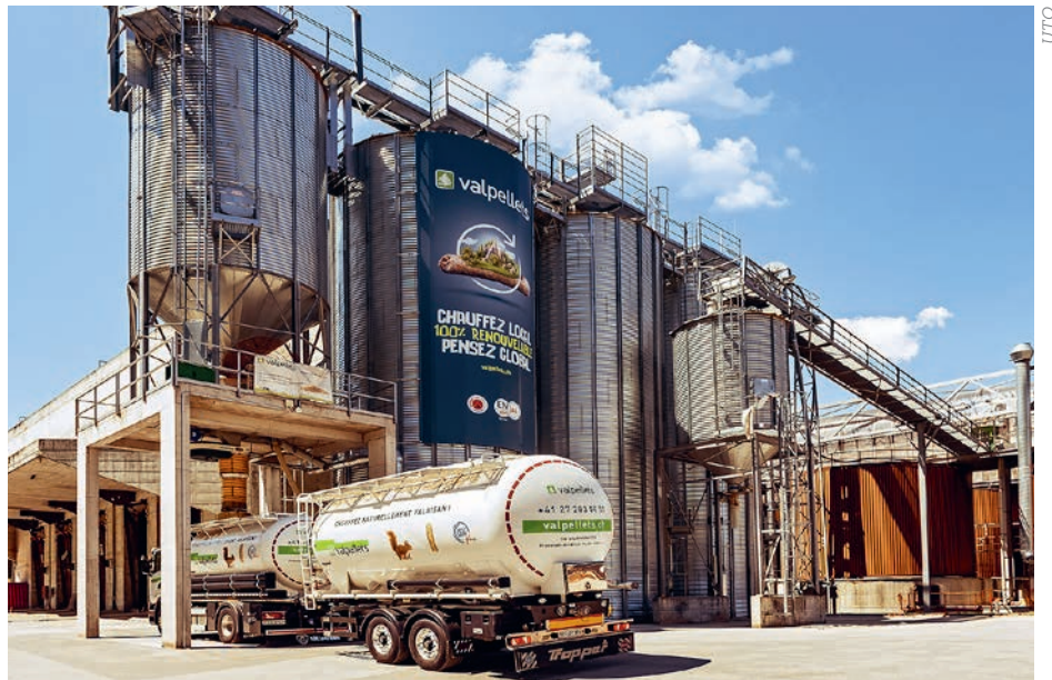
Les projets d'avenir sont essentiellement tournés vers les énergies renouvelables: chauffage à distance (voir illustration en couverture), méthanisation et production de pellets – dont près de 14'000 tonnes, séchés par la chaleur de l'UTO, ont été fabriqués et commercialisés par la société Valpellets SA en 2020.
