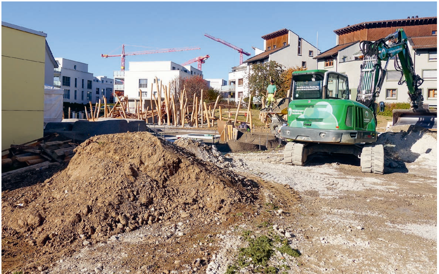
Noch sind die Bau- und Pflanzarbeiten im Gang. Aber schon in wenigen Monaten treffen sich hier Jung und Alt zum Spielen und einheimische Tiere und Pflanzen erobern den Raum.
